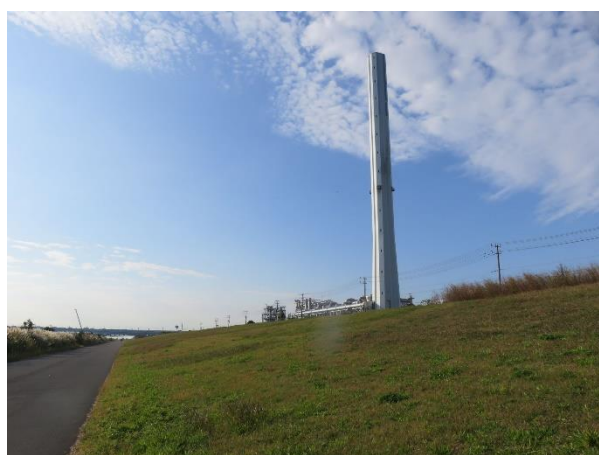
荒川下流ポケットエコスペースの集合場所（入口）の反対（土手）側写真 （白い煙突から約180m手前）
