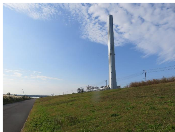
荒川下流ポケットエコスペースの入口の反対側写真（白い煙突から約180m手前）
